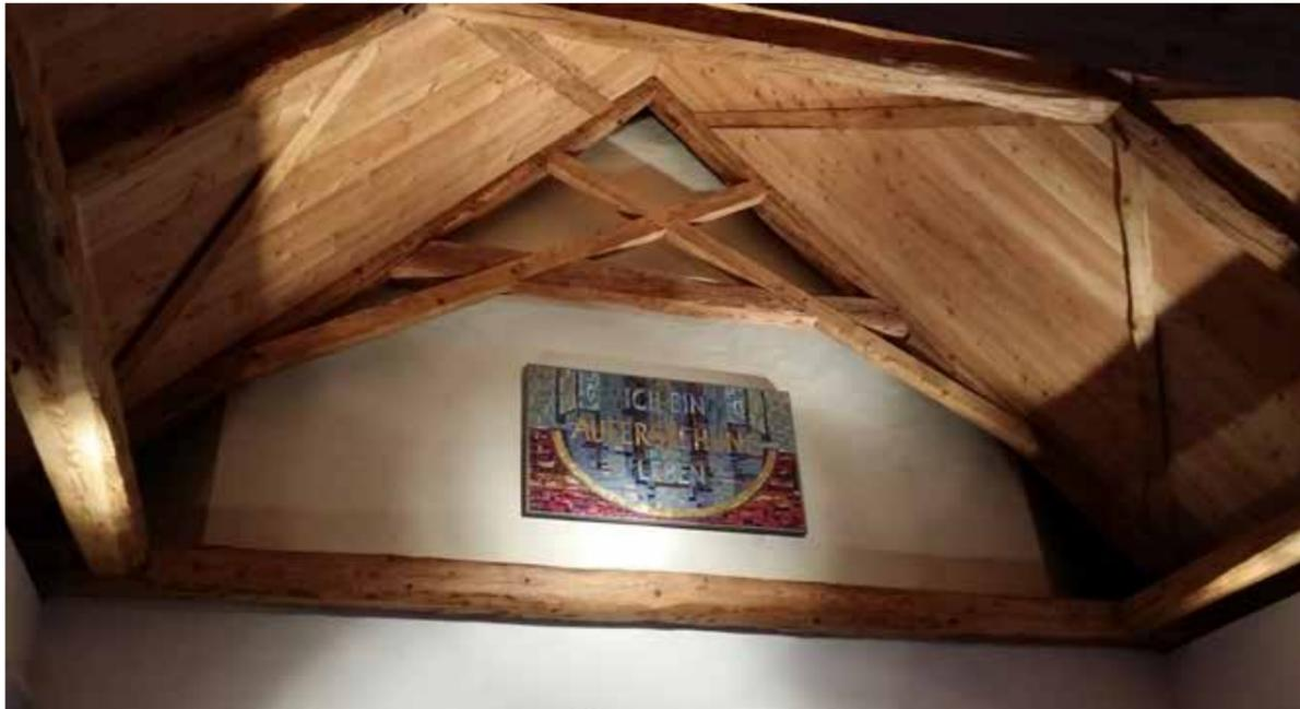
Mit der Adaptierung der Aufbahrungskapelle wurde die bestehende Zwischendecke entfernt, der historische Dachstuhl saniert und ein neuer Natursteinboden verlegt.
